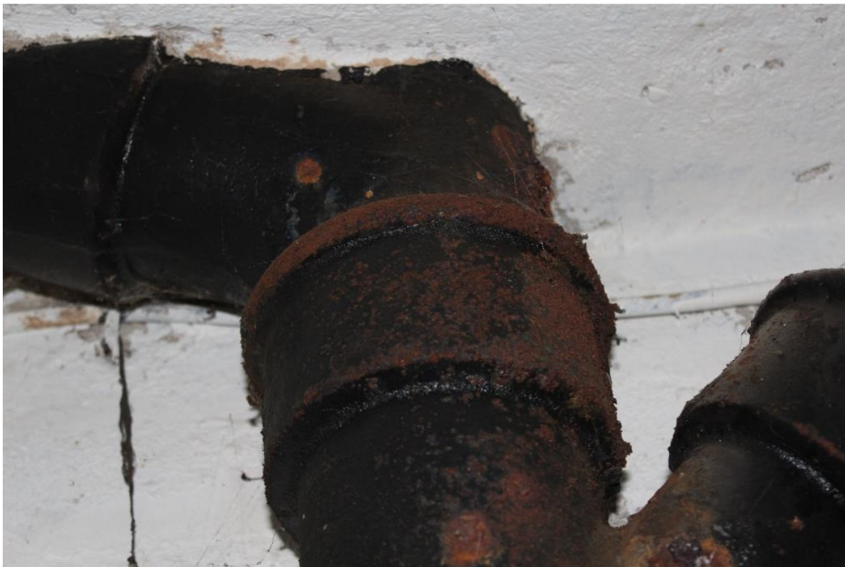
Billede 41. Nærbillede af faldstamme hvor tæring tydeligt ses.
