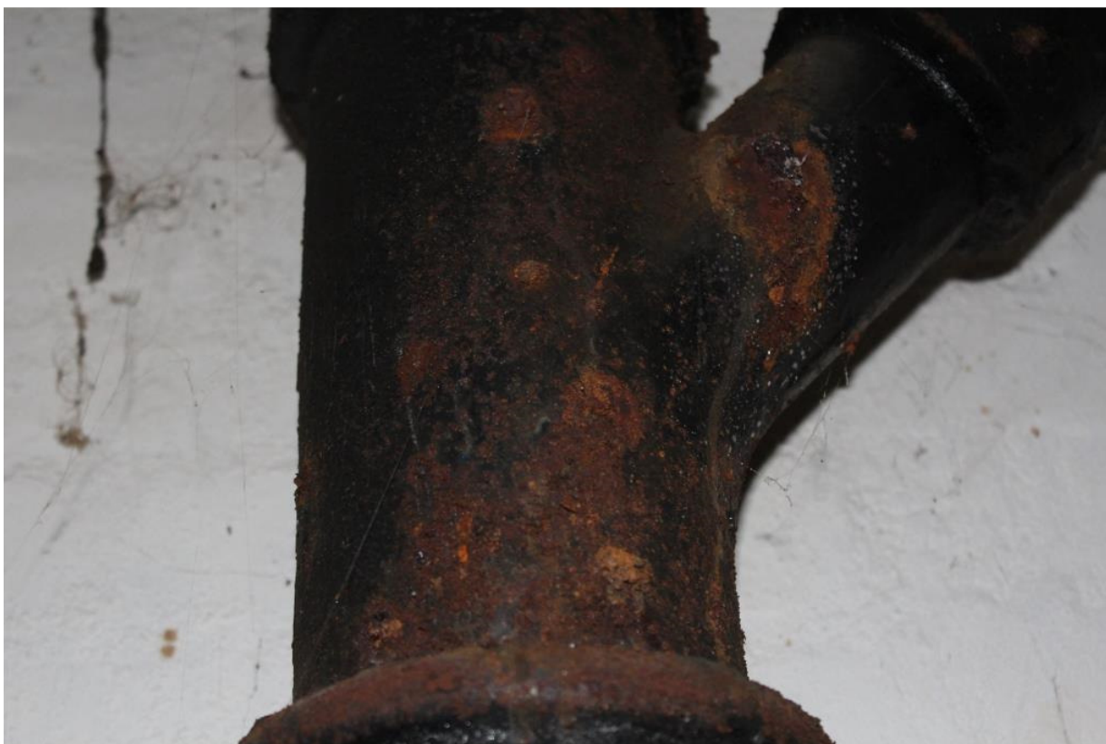
Billede 40. Faldstamme med tæring i punkter.
