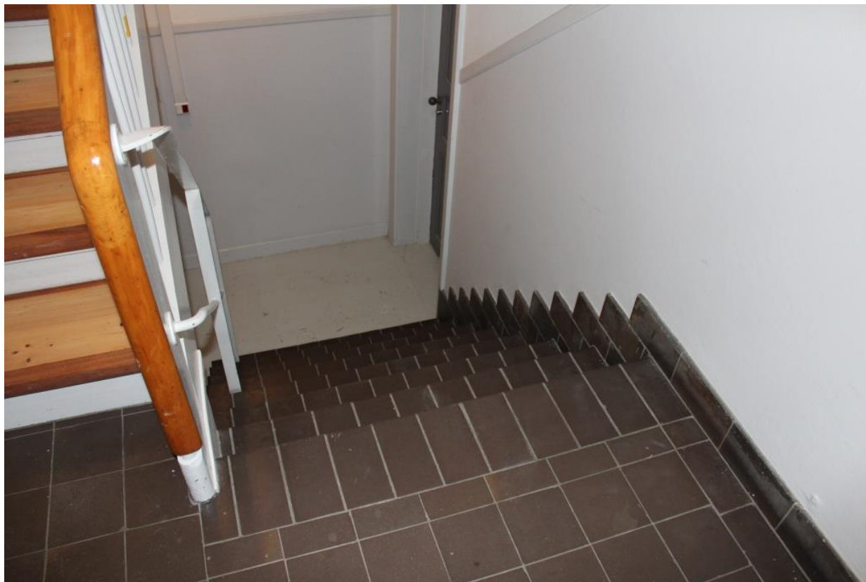
Billede 16. Trappenedgang til kælder i opgang.
