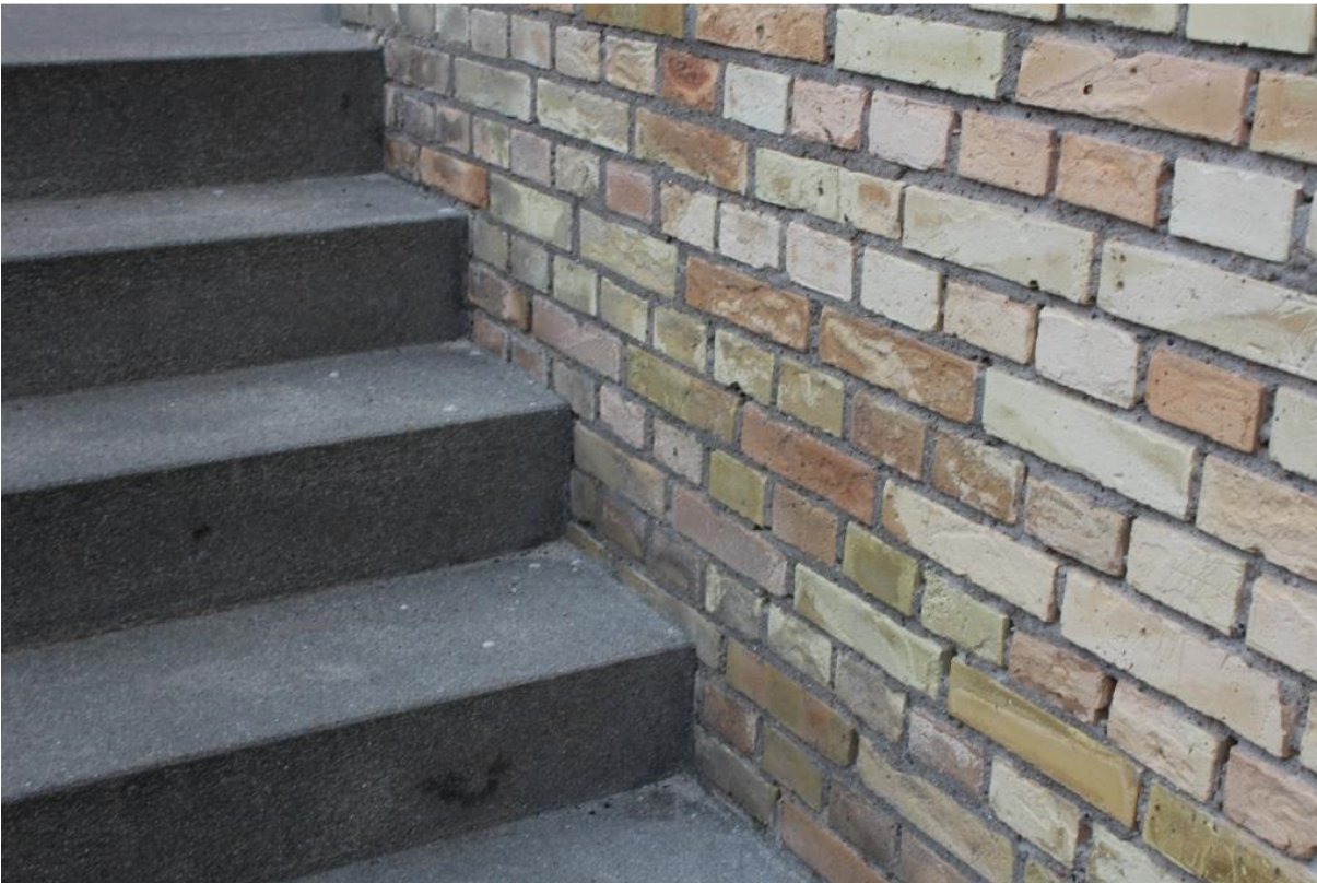
Billede 5. Murværk skadet ved trappe, formentlig forårsaget af saltning.
