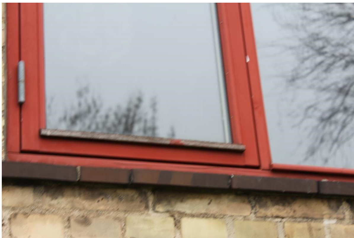
Billede 30. Vindue med manglende maling i bunden.
