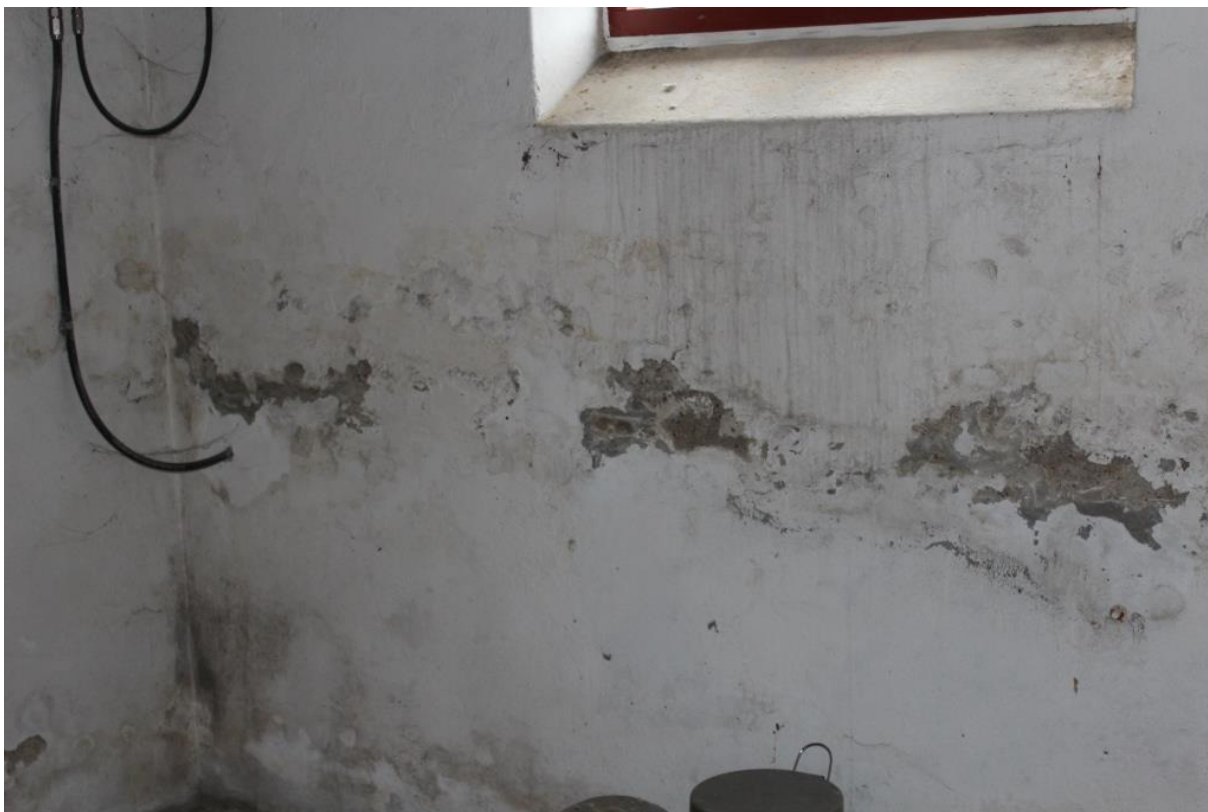
Billede 13. Kraftige fugtafskalninger på væg.
