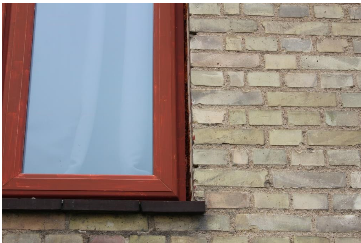
Billede 32. Vinduesfuge mangler.
