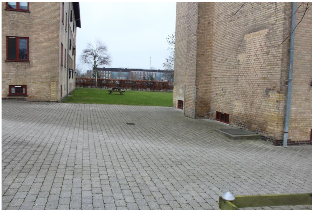
Billede 47. Belægning ved gavl ved nr. 8, har fald ind mod gavlen.
