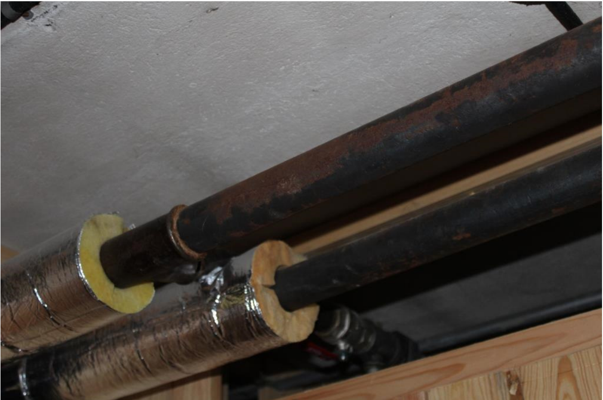
Billede 34. Rør ser pæne ud.
