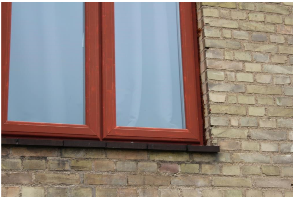
Billede 29. Vindue der trænger til fornyelse af overfladebehandlingen.
