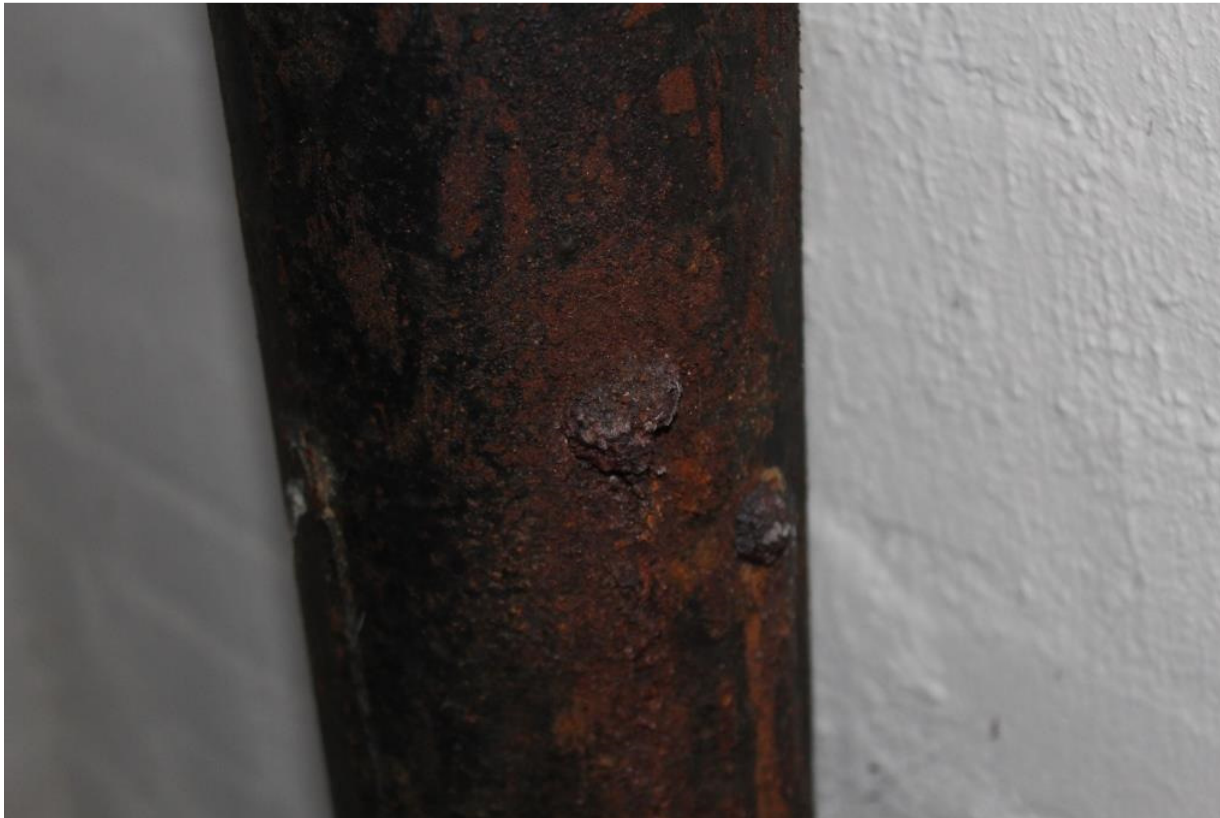
Billede 42. Nærbillede af faldstamme hvor tæring tydeligt ses.
