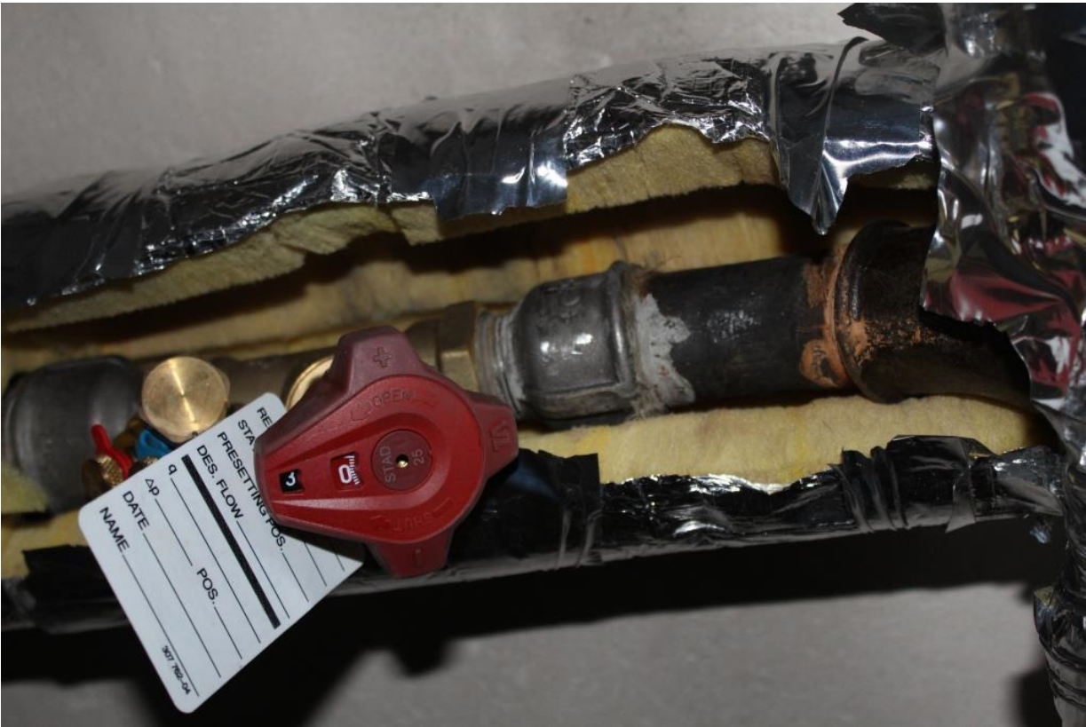
Billede 33. Rør ses generelt at være i god tilstand.
