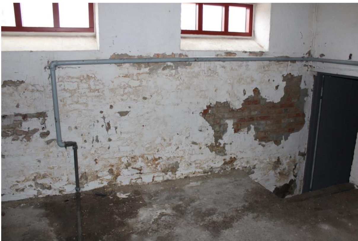
Billede 14. Ydervægge i dyb kælder.
