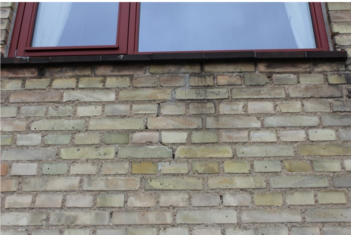
Billede 6. Revne i murværksbrystning.
