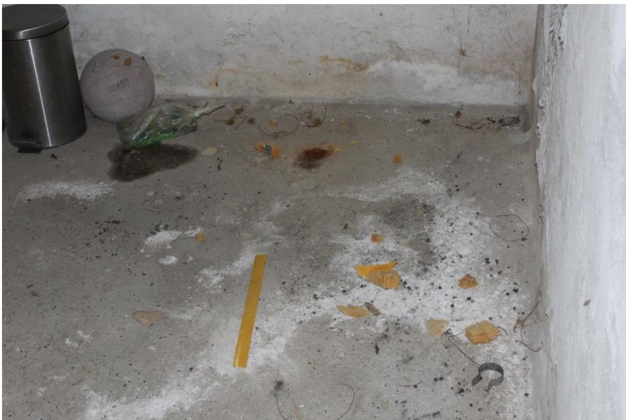
Billede 12. Tegn efter tidligere kraftig opfugtning på kældergulv.
