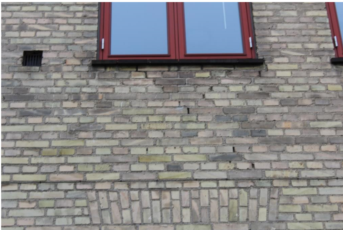
Billede 9. Større revnemønster i murværk.
