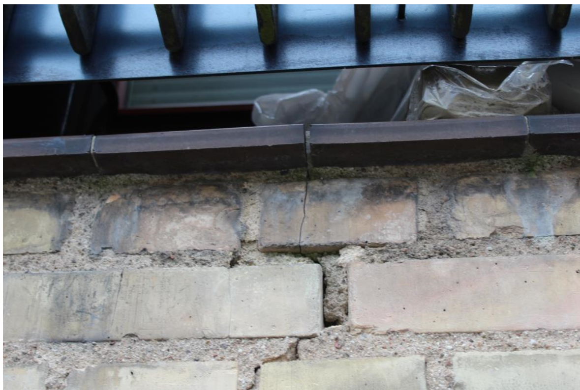
Billede 3. Fugen i sålbænken er dårlig, og murværket herunder har fået vand og er blevet skadet.
