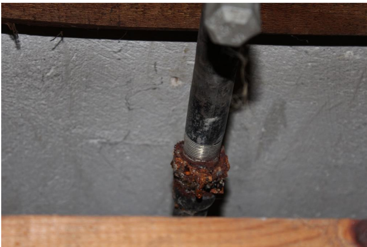
Billede 36. Tæring i samling på rør.
