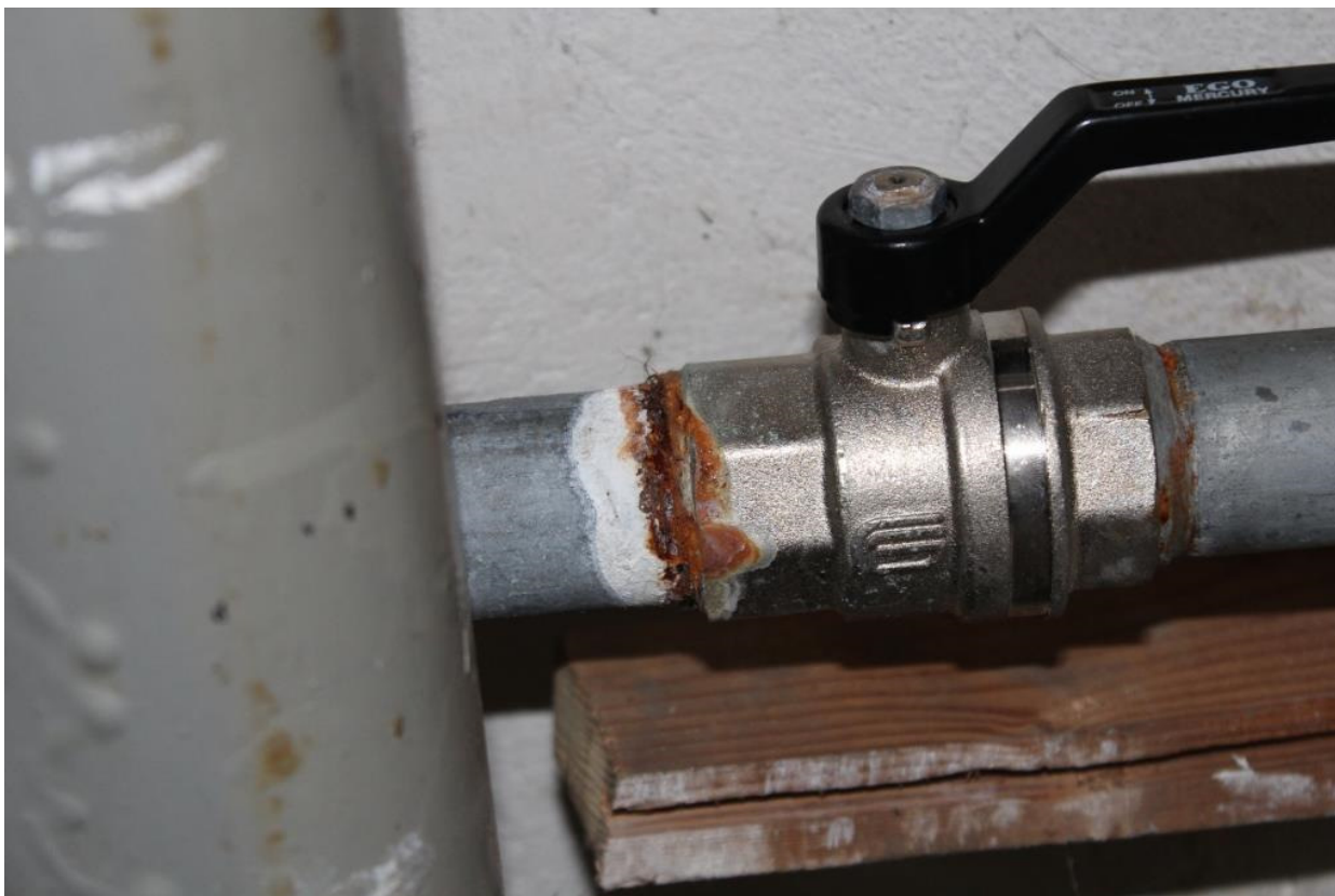
Billede 37. Mindre tæring i rørsamling.
