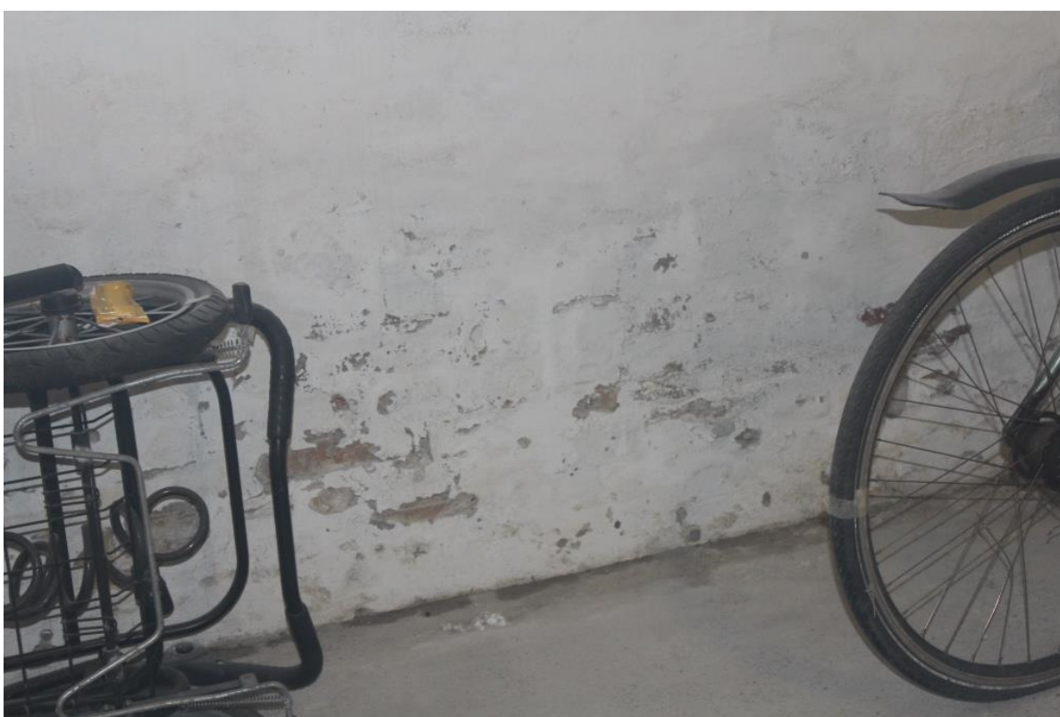
Billede 10. Afskalninger på kældervæg.
