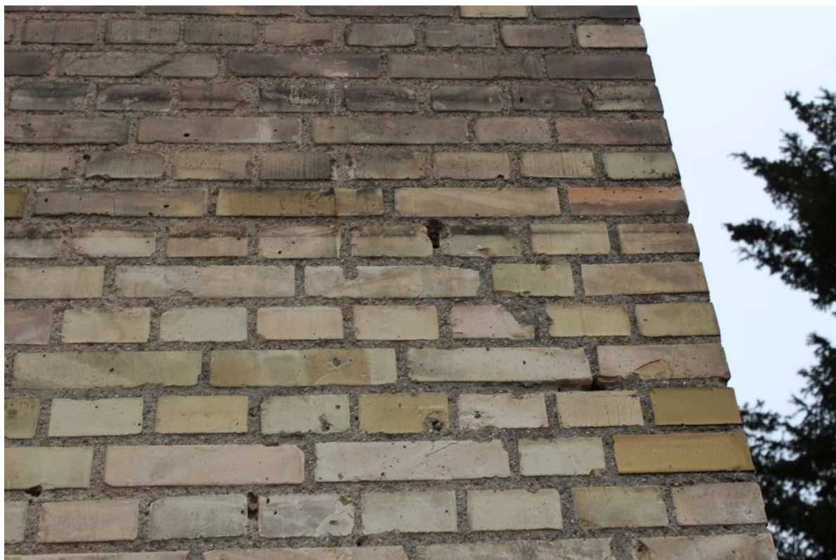
Billede 4. Flere skader i murværket.
