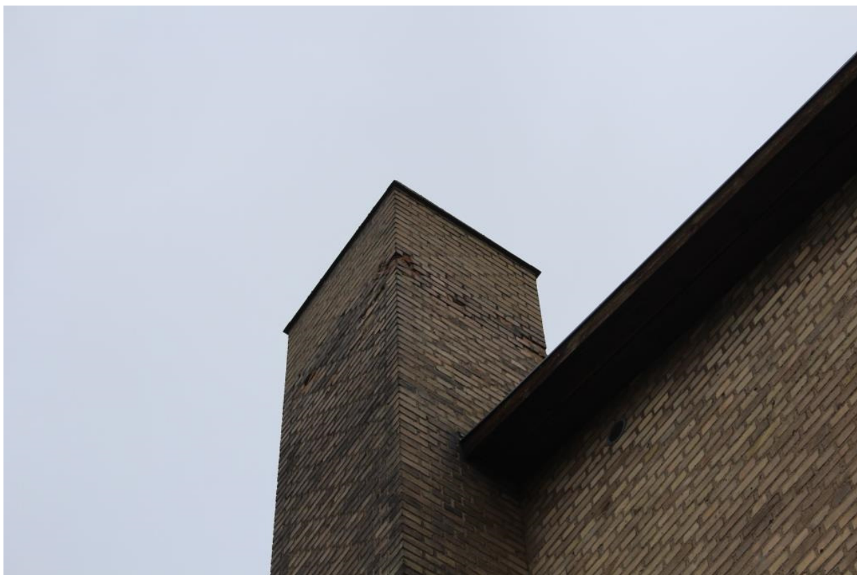
Billede 7. Skader på murværk på skorsten.
