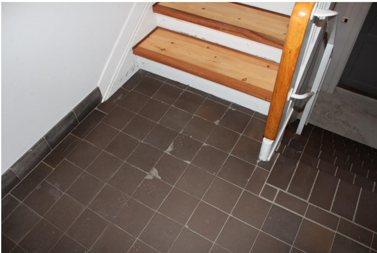
Billede 22. Klinkebelægning med revner og skår.
