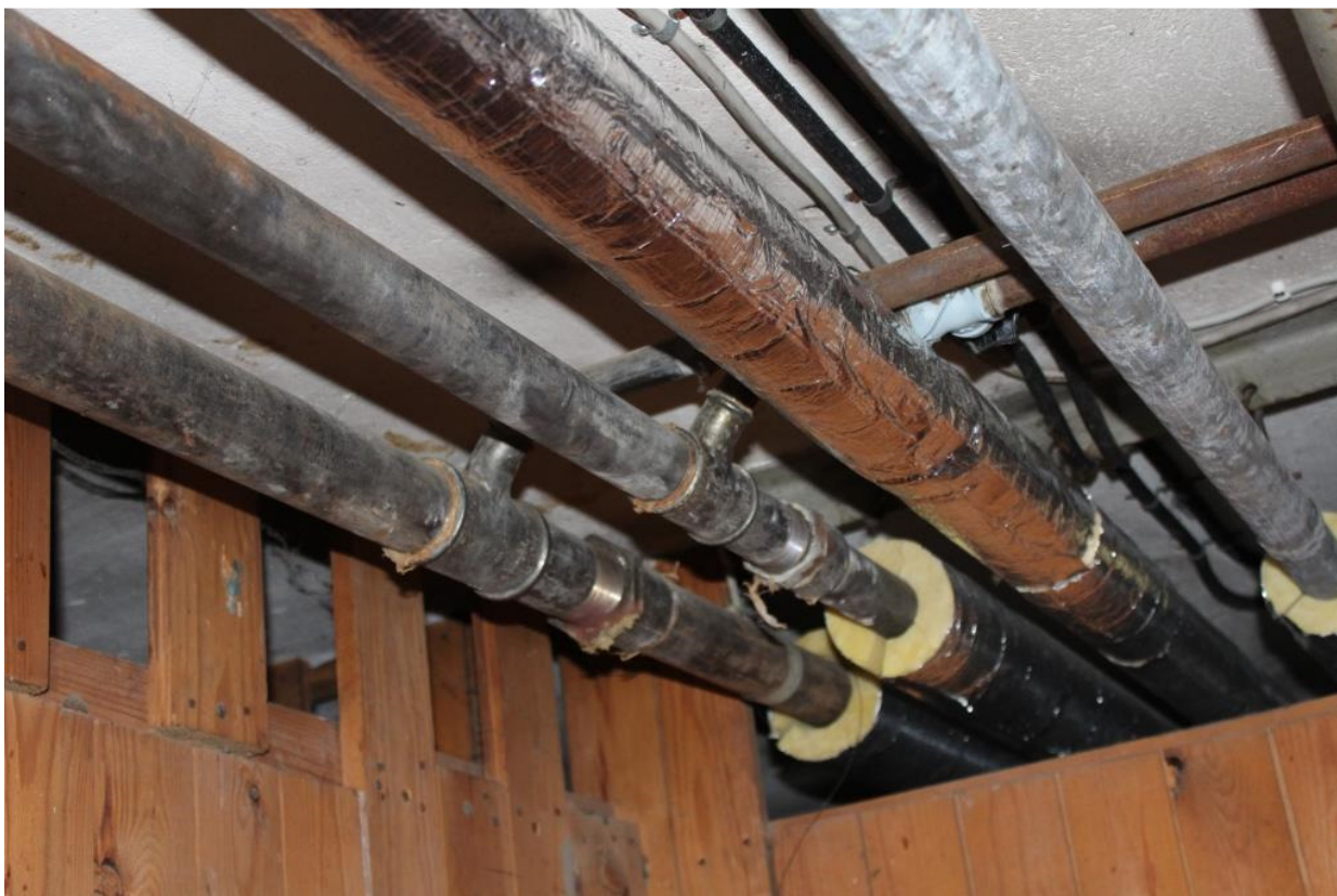
Billede 35. Pæne rør, men isolering mangler.
