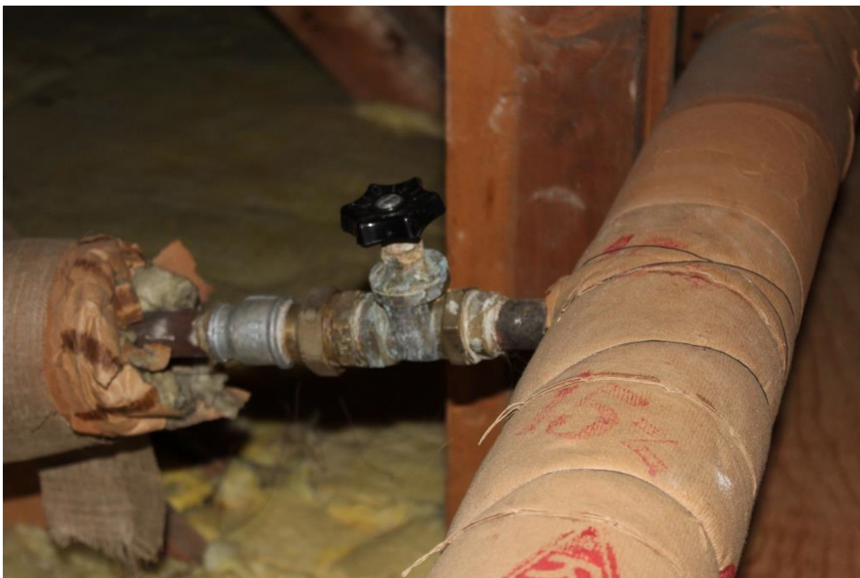
Billede 38. Isolering på rør på loft mangler enkelte steder.
