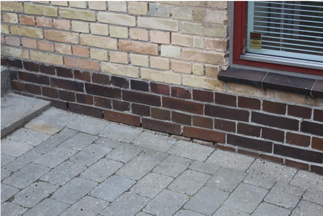
Billede 1. Fuger i murværk ses i stort omfang af være faldet ud, ligesom en del af de lyse sten er skadet i overfladen.
