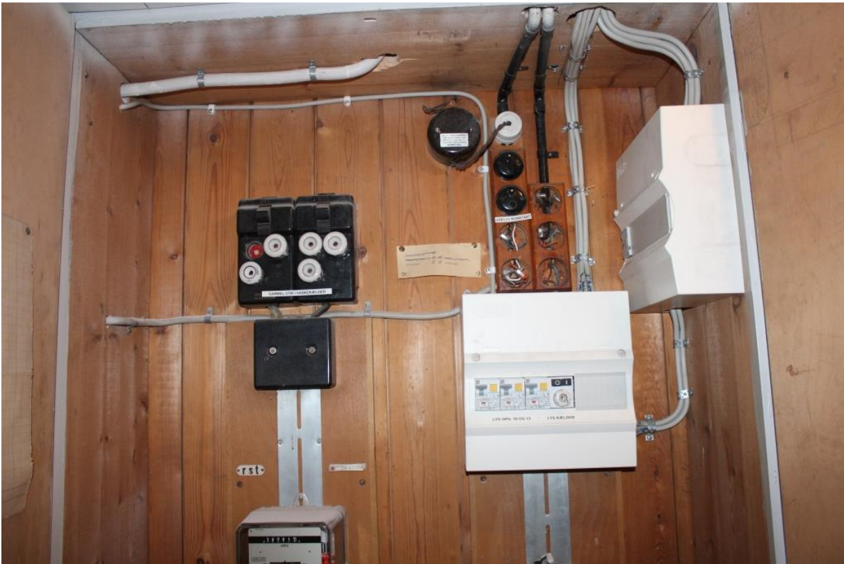
Billede 43. El-tavle i kælder. Ældre sikringer, med ældre ledninger.
