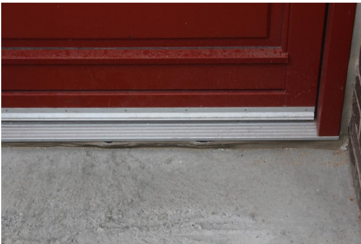
Billede 28. Fuge under nyere dør har sluppet.
