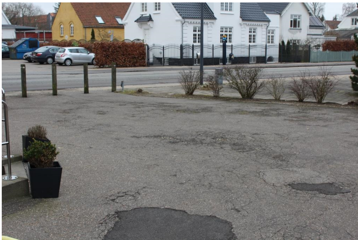
Billede 46. Asfaltbelægning ved nr. 2. Trænger til omlægning.
