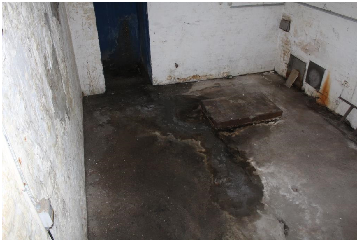
Billede 15. Dyb kælder med vand på gulv, og tegn efter kraftig fugtpåvirkning.
