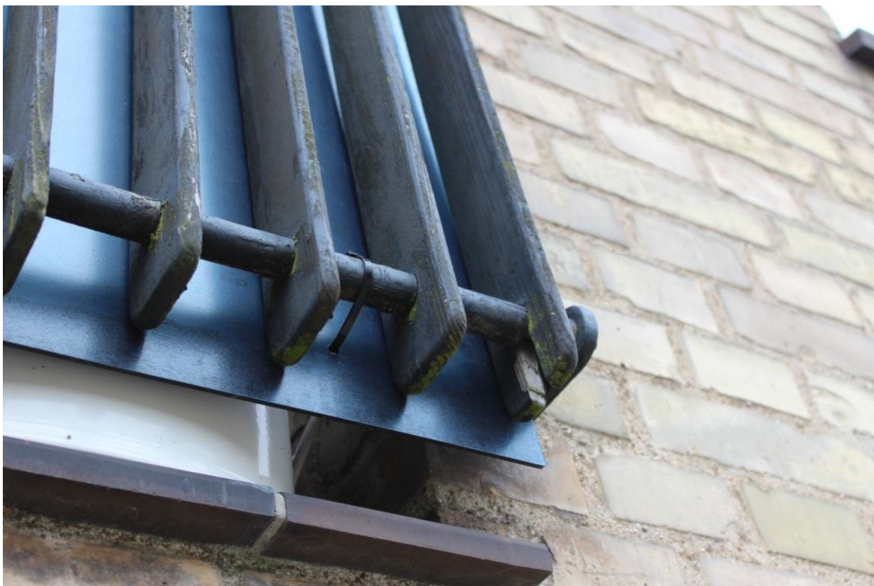
Billede 27. Rækværk foran fransk altandør. Trædel er brækket af.
