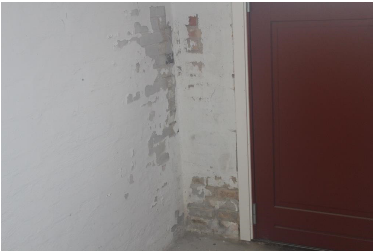
Billede 11. Afskalninger på kældervæg.
