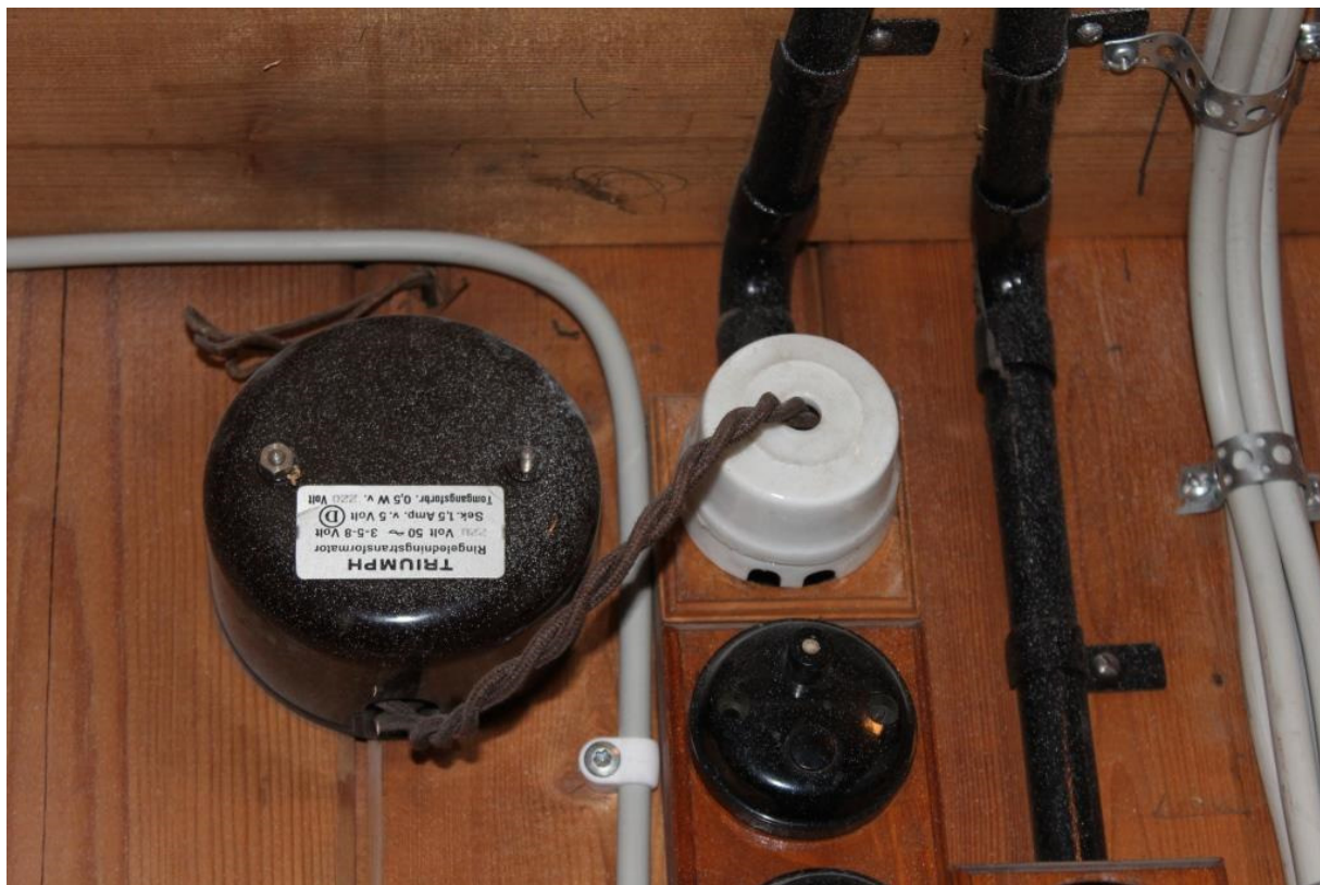
Billede 45. Nærbillede i tavle, men gammel stofledning.
