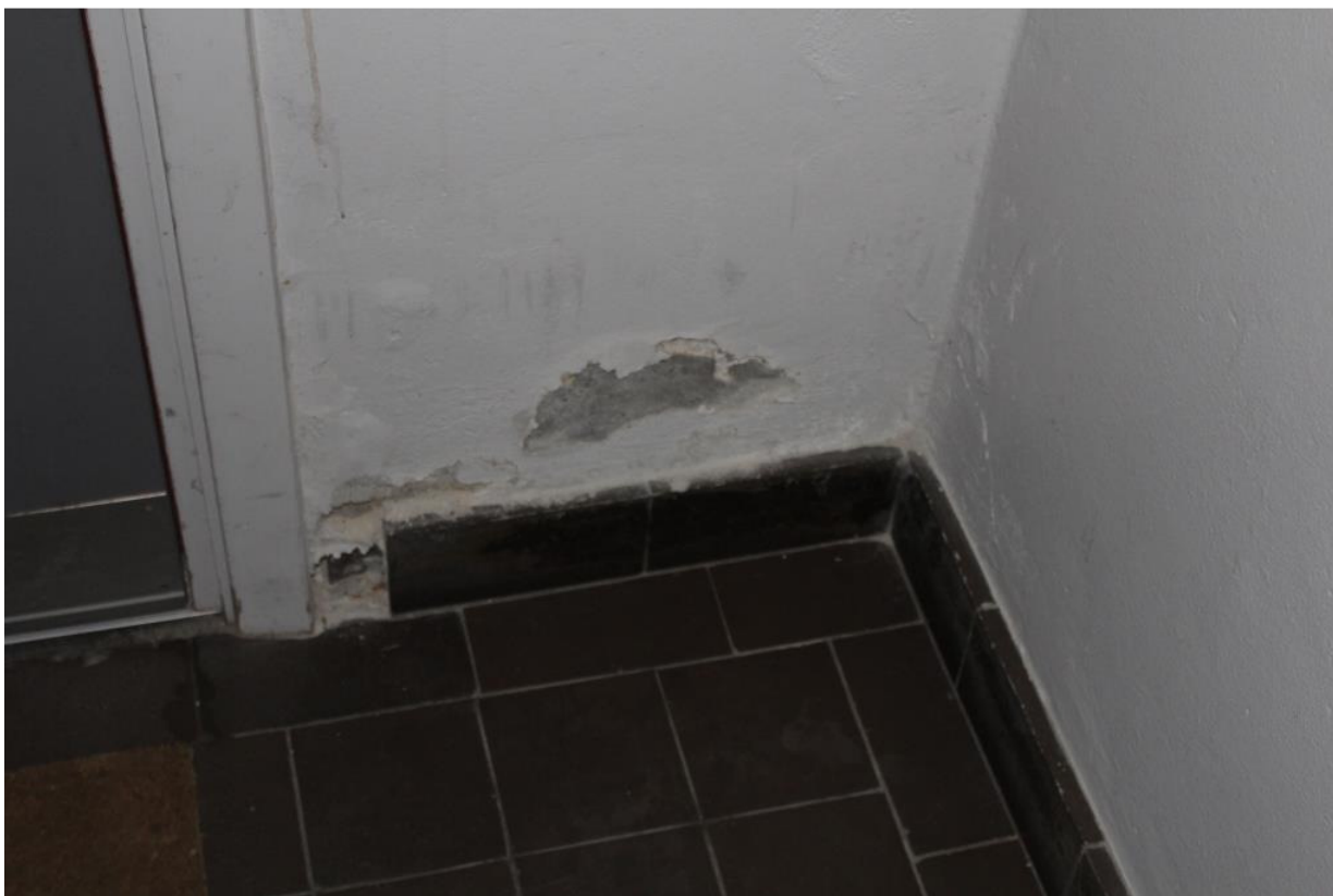
Billede 21. Opfugning og afskalning i bund af væg på trappe.
